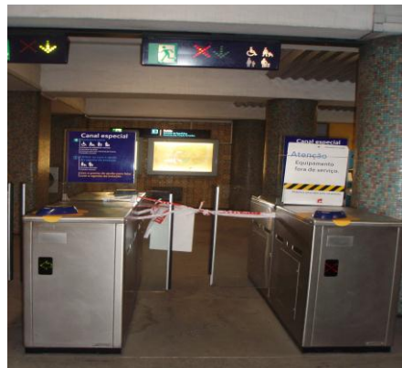
Interior da estação
