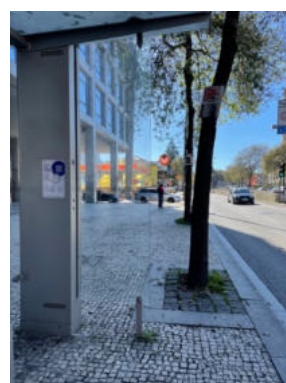
Imagem 56 – Porto. Distância de cerca de 50 metros entre a paragem e o painel informativo.
