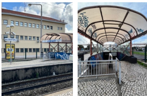
Imagens 40 e 41 – Lisboa. Infraestruturas de mobilidade inoperacionais.
