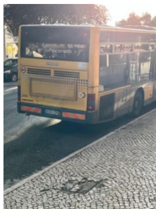
Imagens 15 e 16 – Buracos e ondulações no pavimento.
