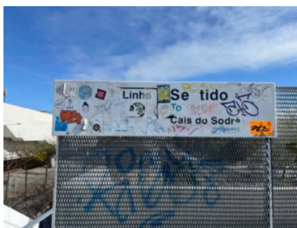
Imagem 75 – Sinalética de encaminhamento deteriorada por atos de vandalismo.
