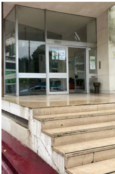
ACT – Centro Local do Grande Porto: acesso por escadas sem corrimão ou outro meio de auxílio a pessoas com mobilidade reduzida; a localização da portaria não permite a visualização de quem necessite de auxílio para aceder ao serviço.
