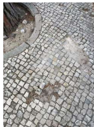
Imagens 15 e 16 – Buracos e ondulações no pavimento.
