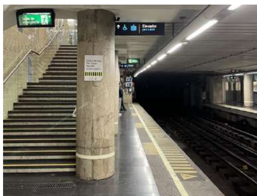
Imagem 37 – Lisboa. Estação de Arroios. Espaço apertado entre a coluna e o cais, qualquer cadeira de rodas pode tombar para a linha.
