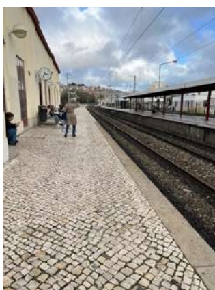
Imagens 66 e 67 – Má prática. Piso sem faixa amarela nem antiderrapante.
