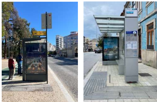
Imagens 21 e 22 – Lisboa e Porto. Percursos táteis que começam a aparecer em paragens remodeladas.
