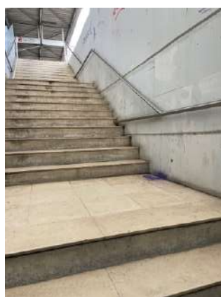
Imagens 66 e 67 – Má prática. Piso sem faixa amarela nem antiderrapante.
