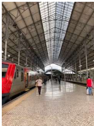
Imagem 69 – Ausência de assentos no cais de embarque.
