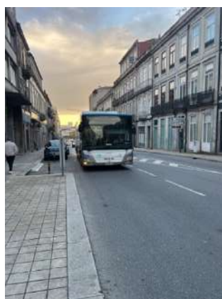
Imagem 17 – Porto. Piso menos degradável.
