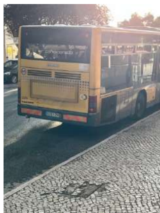
Imagens 15 e 16 – Buracos e ondulações no pavimento.
