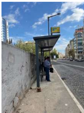
Imagem 13 – Lisboa. Passeio estreito e lancis não rebaixados.
