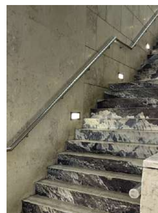
Imagem 68 – Boa prática. Piso com entalhes duradouros.
