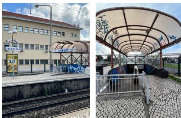
Imagens 40 e 41 – Lisboa. Infraestruturas de mobilidade inoperacionais.
